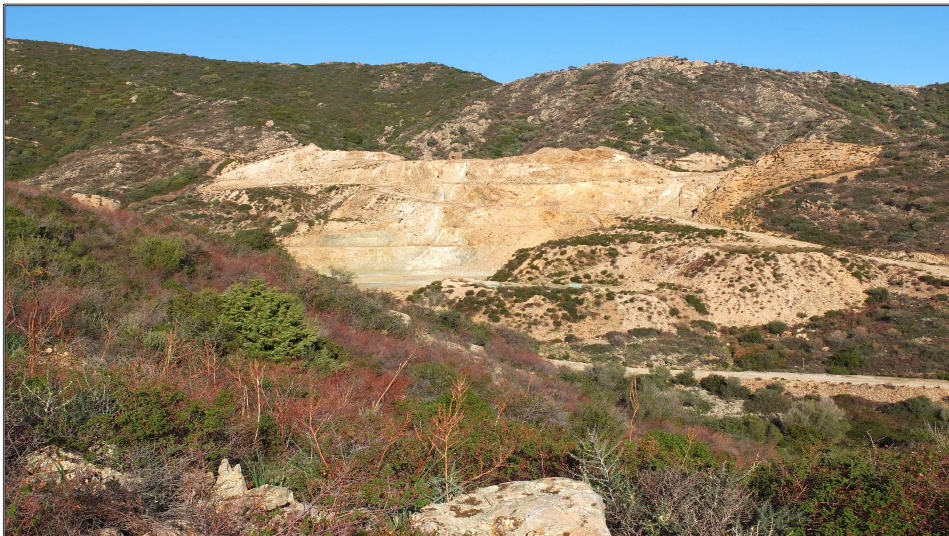
Foto n°47 – Vista del cantiere di Crapitudine in basso la pista di accesso piazzale di base e a mezza costa la pista di accesso alle parti alte del cantiere.
