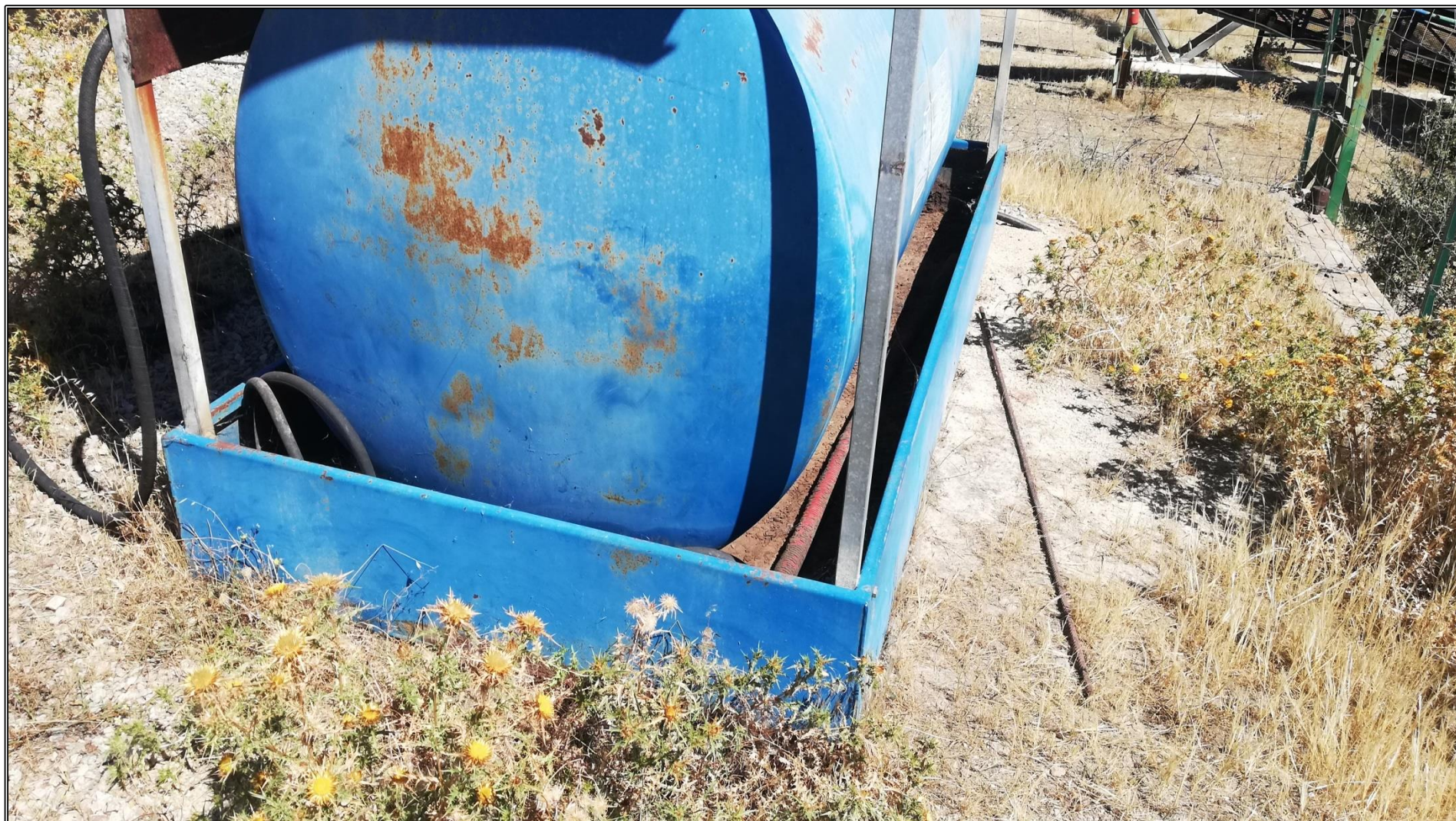
Foto n°25 – Dettaglio vasca serbatoio gasolio.
