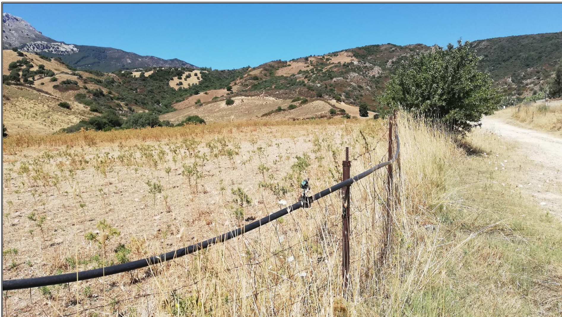
Foto n°18 – Tubazione con spruzzatori per l'innaffiamento per l'abbattimento delle polveri nella strada di accesso.
